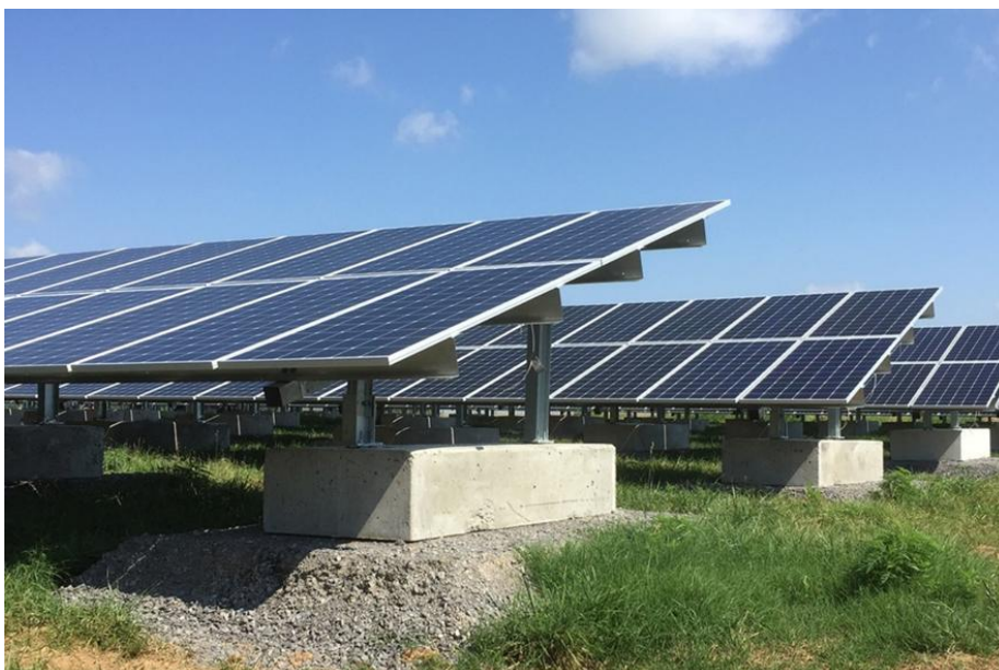
Slika 17 Primer gravitacionih temelja za solarne panele
